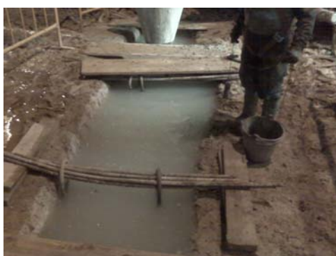
Fig.7. Aspecte del polímer en excavació de panalla (Font: Clabsa)
