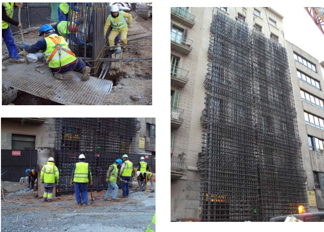
Fig.8. Col·locació de l'armadura de les pantalles. Detall de solapament dels mòduls. (Font: Clabsa)
