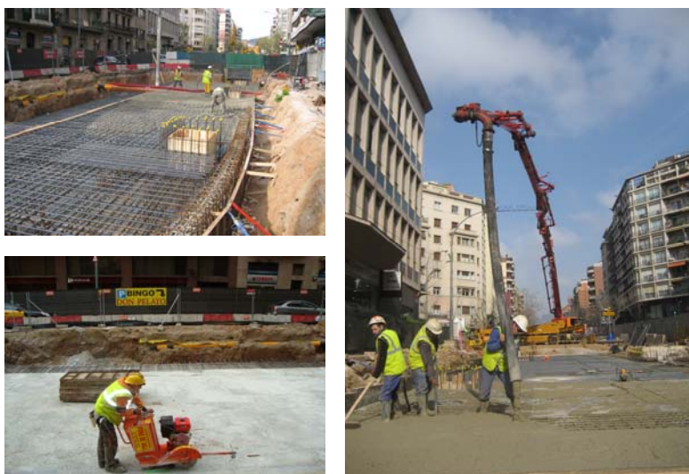
Fig.13. Procés constructiu de la llosa. S'observa el formigonat de la llosa i l'"espaldín" a la vegada, i el tall posterior de la coberta. (Font: Clabsa)
