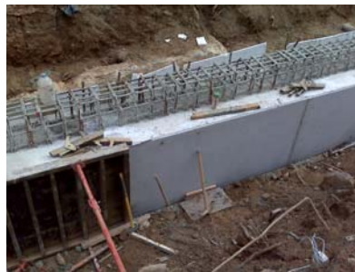
Fig.11. Execució de la biga de coronació
