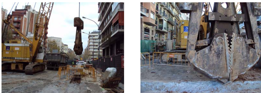
Fig.6. Pantalladora de cables i detall cullera bivalva (Font: Clabsa)
